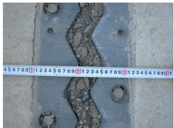
신축이음 이동량 측정
