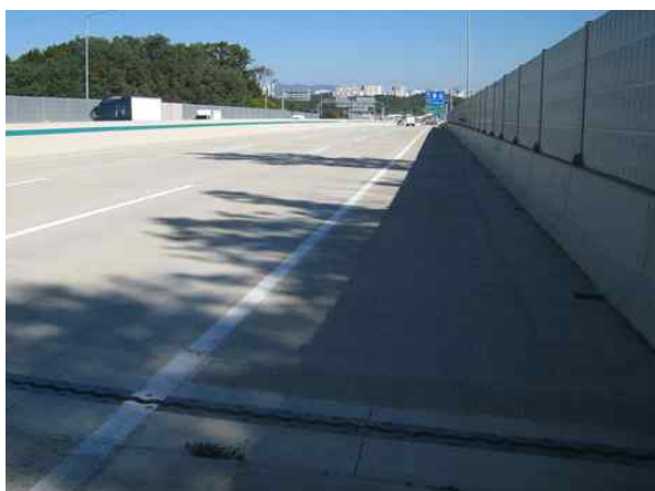
방호벽 상태양호 - 금회
