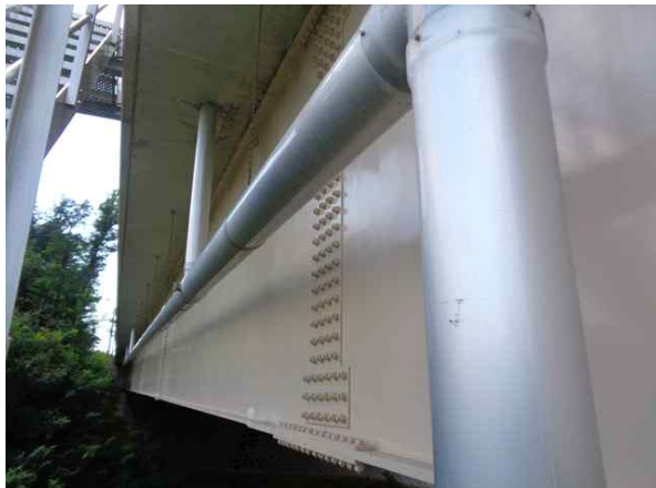
배수관 상태 양호 - 금회
