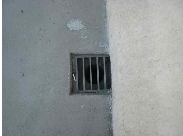
배수구 상태 양호 - 금회
