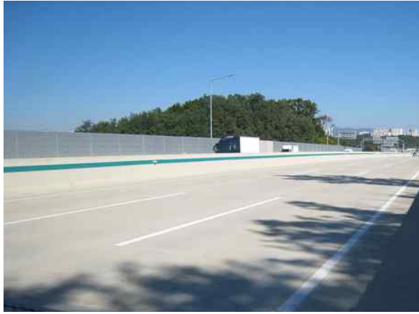
중분대 상태양호 - 금회
